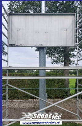
Verwijderen oude frontplaat en achterliggende elektronica
