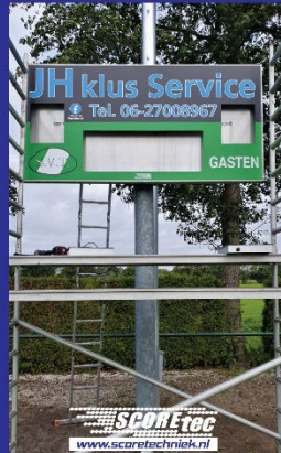
Plaatsen nieuwe frontplaat in bestaande behuizing en constructie
