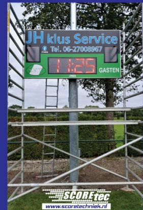
Plaatsen SCOREtec scorebord modules in nieuwe frontplaat
