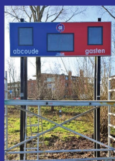
Plaatsen nieuwe frontplaat in bestaande behuizing en constructie
