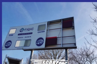
Verwijderen oude frontplaat en achterliggende elektronica
