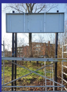
Verwijderen oude frontplaat en achterliggende elektronica
