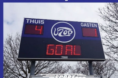
Plaatsen nieuwe frontplaat en nieuwe scorebord modules in bestaande behuizing en constructie
